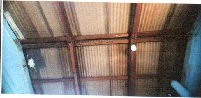
Foto1: Cubiera de lamina
