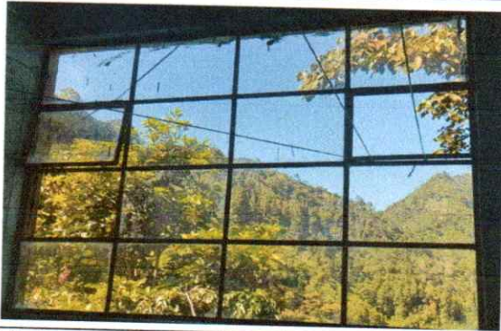
Foto 3: Ventanas, sustitución de vidrios
