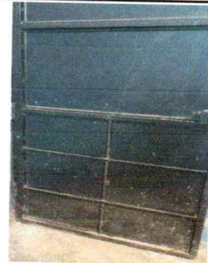
Foto 2: Puerta de metal, Sustitución de puerta de metal
