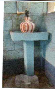
Foto 4: Repapación de cocina, sustitución de pila de cemento de un lavadero
