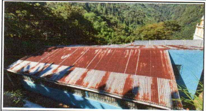
Foto 8: mantenimiento de techo de lamina
